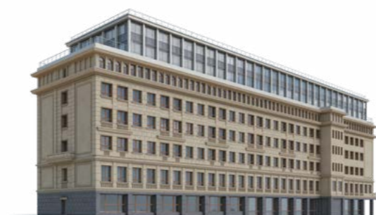
ВИД НА ФАСАД С МУЗЕЙНОГО ПЕРЕУЛКА
